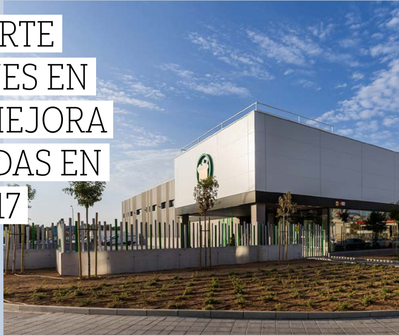
La tienda del Polígono de Son Valentí incorpora placas solares en su cubierta.
