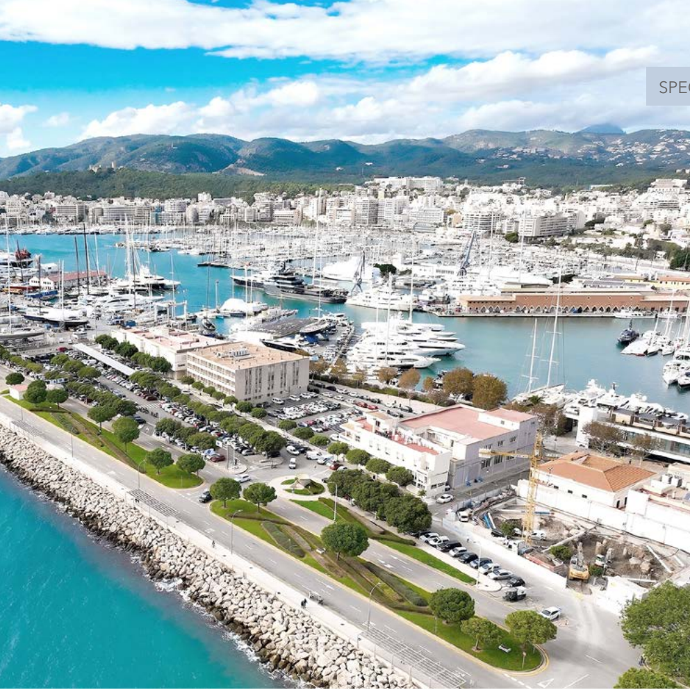
Imagen aérea del actual puerto de Palma. Foto: Autoridad Portuaria de Baleares.
